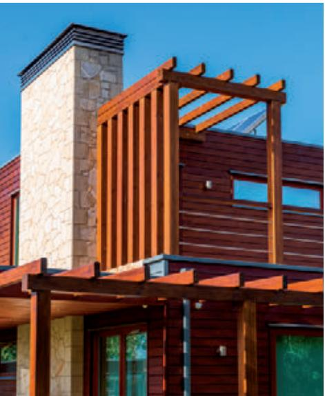
Las casas en ITS™, montadas con las dos caras de las paredes acabadas, pueden ser entregadas totalmente equipadas, con carpintería exterior incluida, así como los canales para la instalación eléctrica empotrada, ofreciendo una rapidez de ejecución sin tiempo de fraguado o de secado característico de la construcción con conglomerantes húmedos (construcción convencional).
